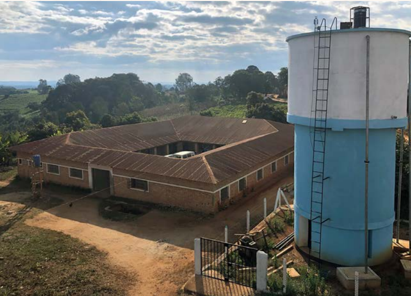
Blick auf Dekanatsgebäude und neuen Wasserturm in Lupembe, Tansania.
